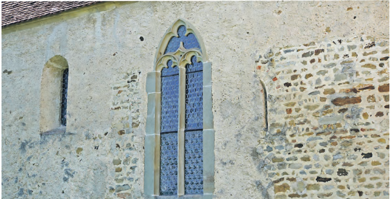
Spuren der Baugeschichte von St. Martin. Unten: Reste von verputztem Bruchsteinmauerwerk und Öffnungen aus verschiedenen Bauphasen. Oben: Steinmetzzeichen an den Gewölberippen im Chor und Abbundzeichen am Glockenstuhl im Turm.
